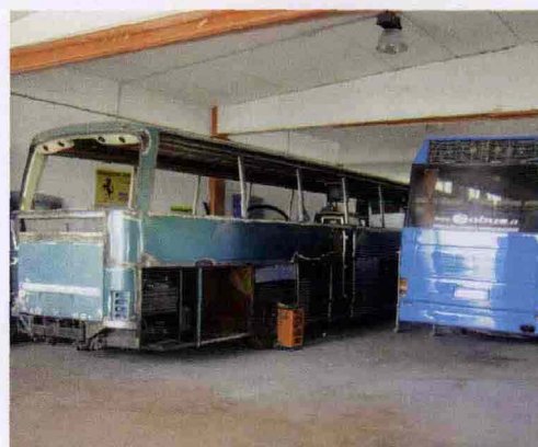
Sostituzione pannellatura, ripristino bagagliai, pavimentazione in legno e linoleum, sabbiatura sono solo alcuni dei servizi offerti per i veicoli industriali
